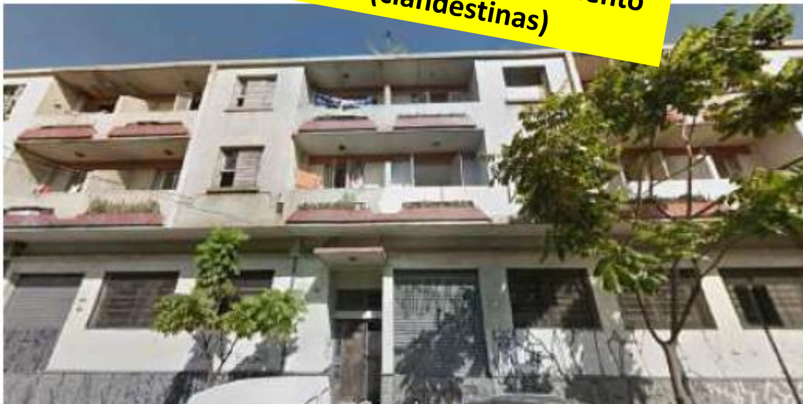
Foto 11 – Rua Barra do Tibagi
